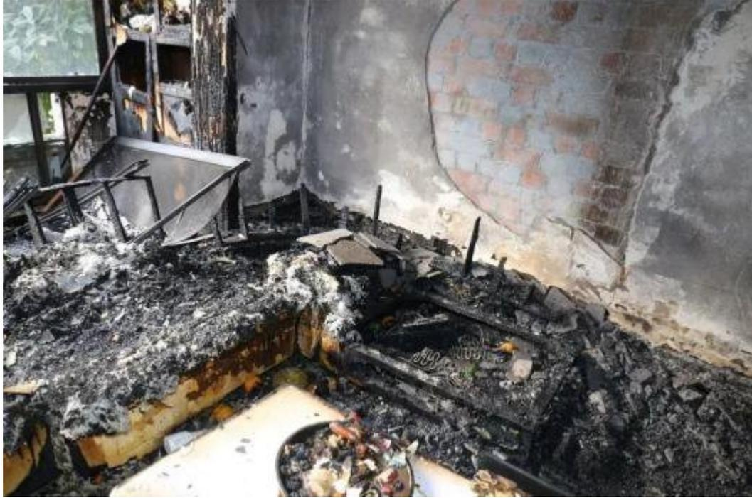
2022年11月13日凌晨，廣東潮州市楓溪區詹厝村一電動自行車修理門店產生火災，形成3人逝世。經查，開始認定火災原由於：修理店經營者張某某在店門口內側給電動自行車鋰電池充電過程中，鋰電池產生熱失控起火，點燃周邊可燃物延伸成災。
